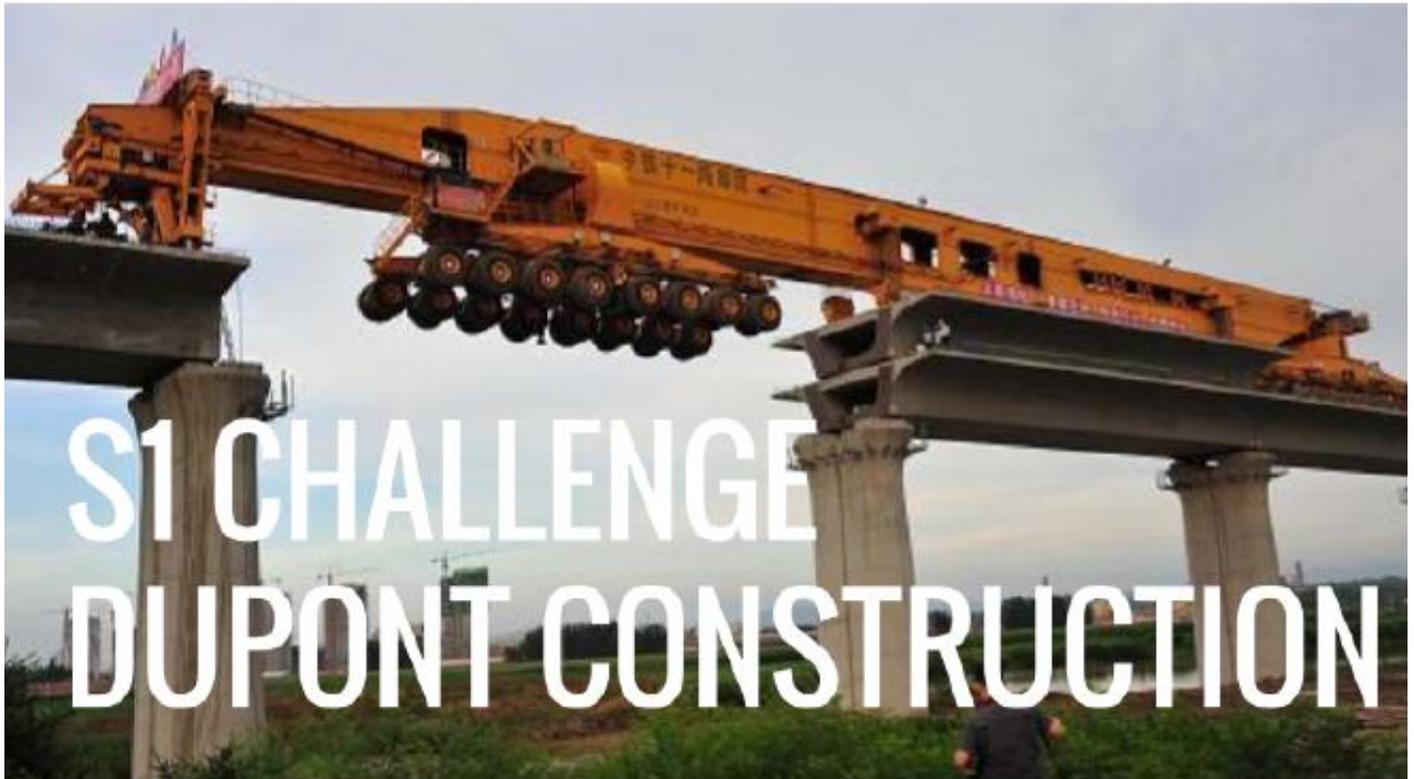
LJ900/32 (见上图) 是一个中国工程机械公司发明的一种建桥机器。这种机器可以在不使用吊车的情况下快速的建桥。可以通过以下视频了解此种机器的工作情况。
